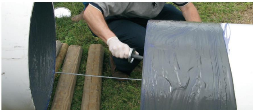
A medida que aumenta el diámetro de la tubería, asegúrese de tener un tamaño de cuadrilla más grande para respaldar la aplicación correcta de imprimador y solventes con un extractor de tuberías. El instalador profesional debe ser capaz de ensamblar con éxito tuberías y accesorios de gran diámetro siguiendo las instrucciones del Procedimiento para la unión de tuberías que se enumeran al comienzo de esta guía junto con las siguientes recomendaciones adicionales.
